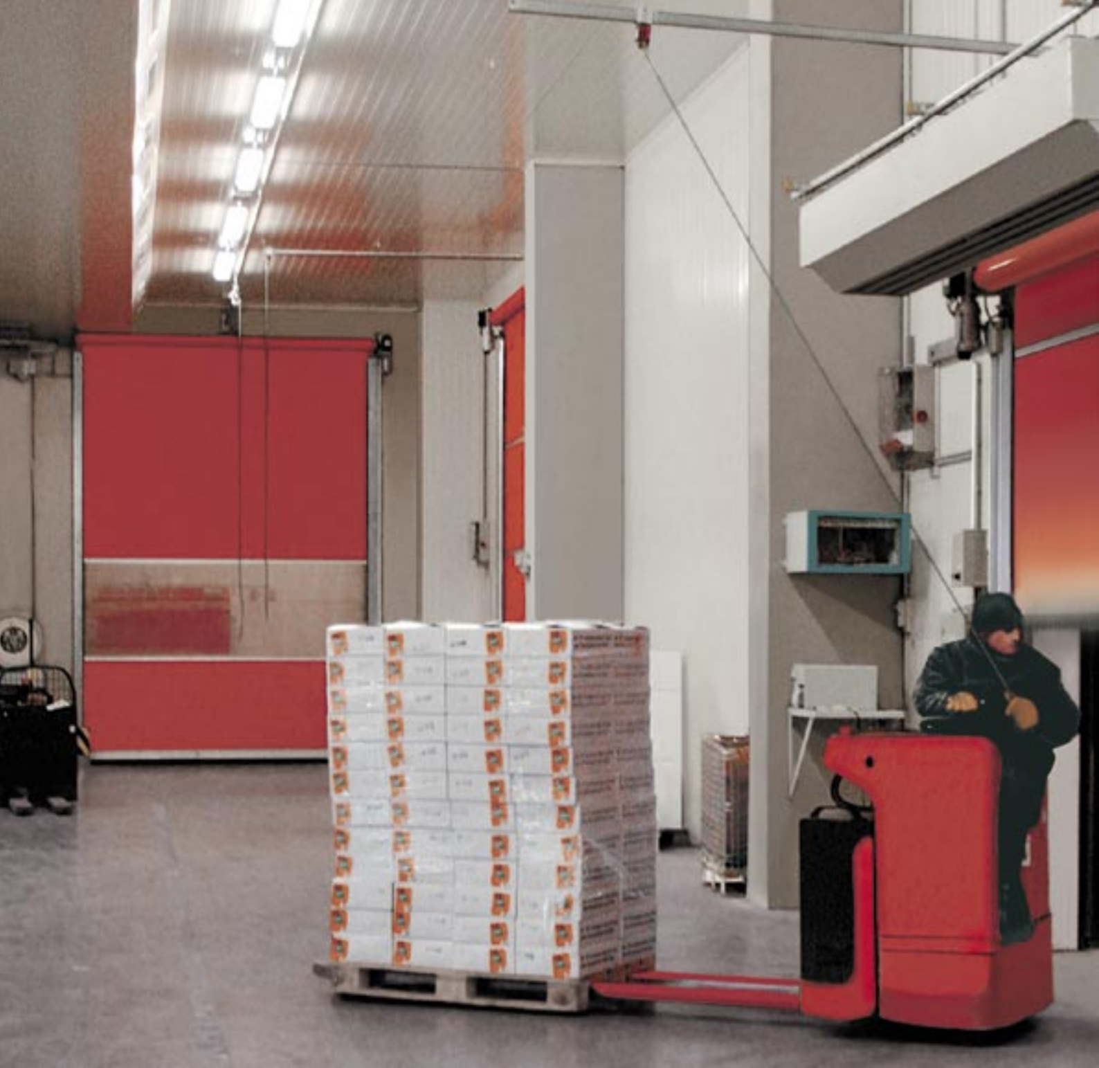
Vertikální rychloběžná vrata ve dvojitěm použití: s transparentním vizuálním polem v oblasti normální okolní teploty a s celistvým závěsem před skladem mraženého zboží.
