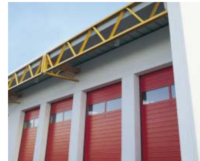
Sandwich-Verglasung mit Iso-Doppelscheiben, 16 mm k = ca. 2,85 W/m²K
