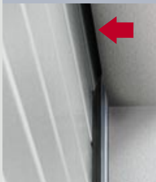
Těsnění překladu
