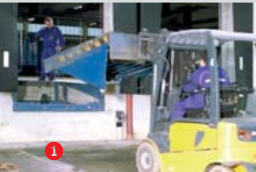
Demontuje se starý nakládací můstek
