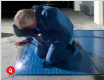
Navazuje se na obvodový úhelník - hotovo!
